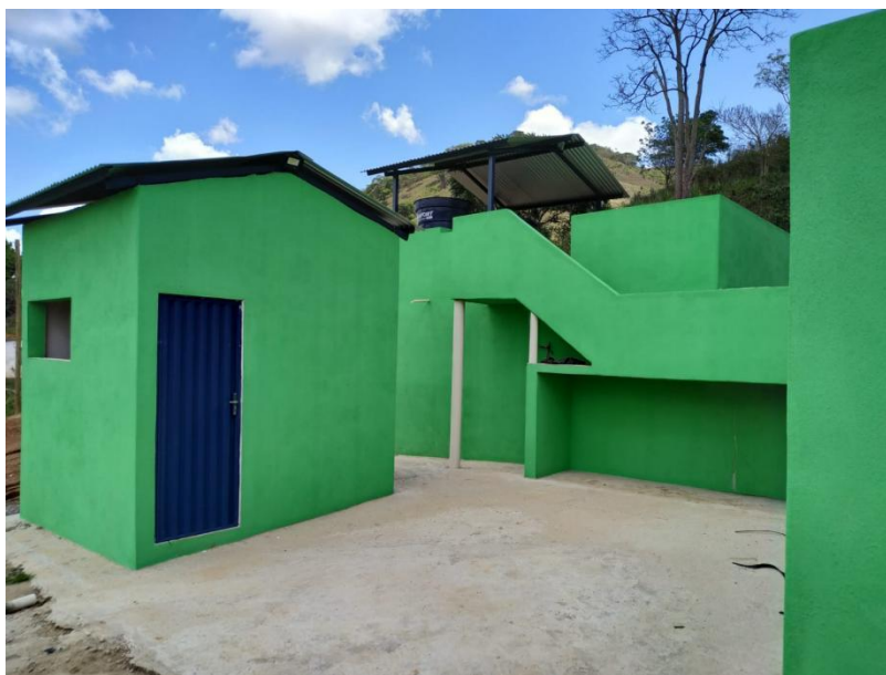
Figura 6 - Estação de Água Limpa
